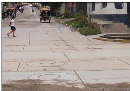
*Foto: Vista de Cámaras de Inspección de Sistema de Alcantarillado de Ciudad de Jaén.*
