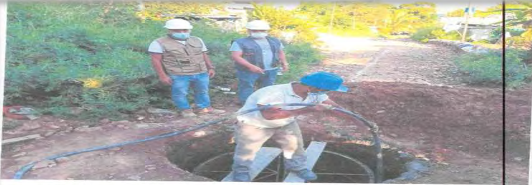
TOMA 09: SE MUESTRA EN LA IMAGEN VACEADO DE MURO DE BUZON, PRESENCIA DEL SUPERVISOR RESIDENTE
