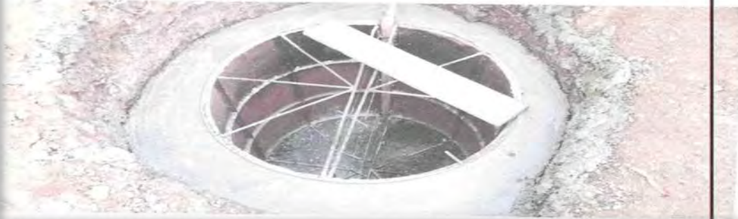
TOMA 09: SE MUESTRA EN LA IMAGEN VACEADO DE MURO DE BUZON, PRESENCIA DEL SUPERVISOR RESIDENTE
