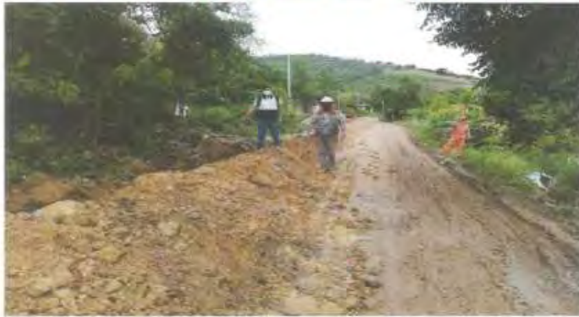
FOTOGRAFIA N° 17.- Ing. Residente verificando colocación de tubería de agua juntamente con el Supervisor - Tramo II
