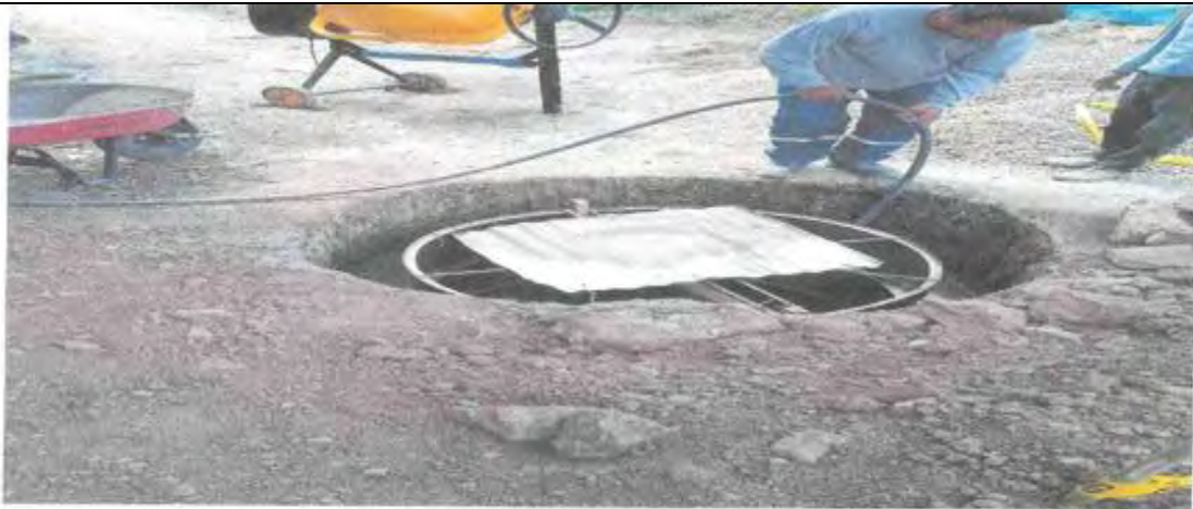
TOMA 07: SE MUESTRA EN LA IMAGEN VACEADO DE MURO DE BUZON e= 0.20 m
