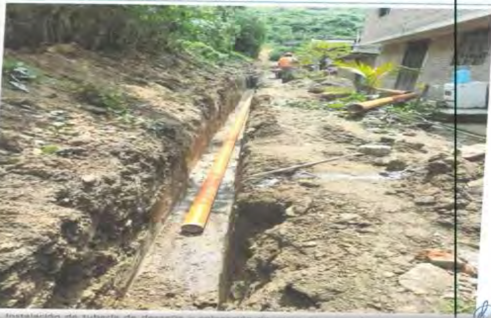
Instalación de tubería de drenaje y recolección de aguas pluviales
