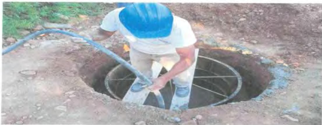
TOMA 08: SE MUESTRA EN LA IMAGEN VACEADO DE MURO DE BUZON e= 0.20 m
