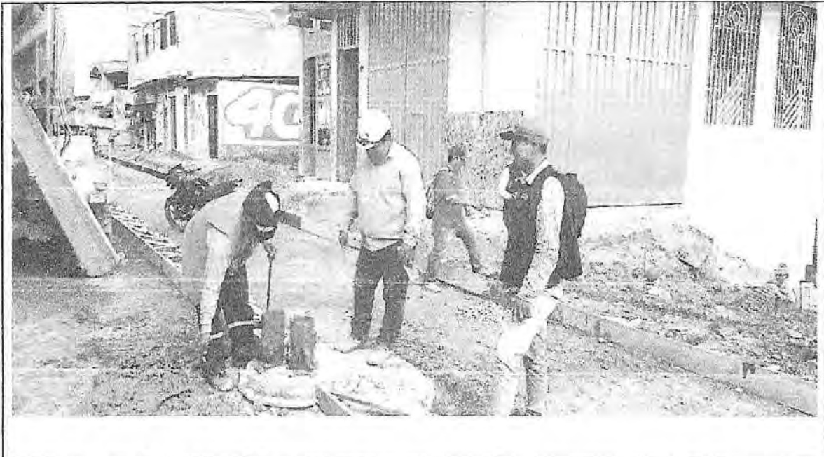
FOTOGRAFÍA 41 : Extracción de muestras para control de calidad en vaciado de concreto en pavimento Calle Unión Cdr 01.
