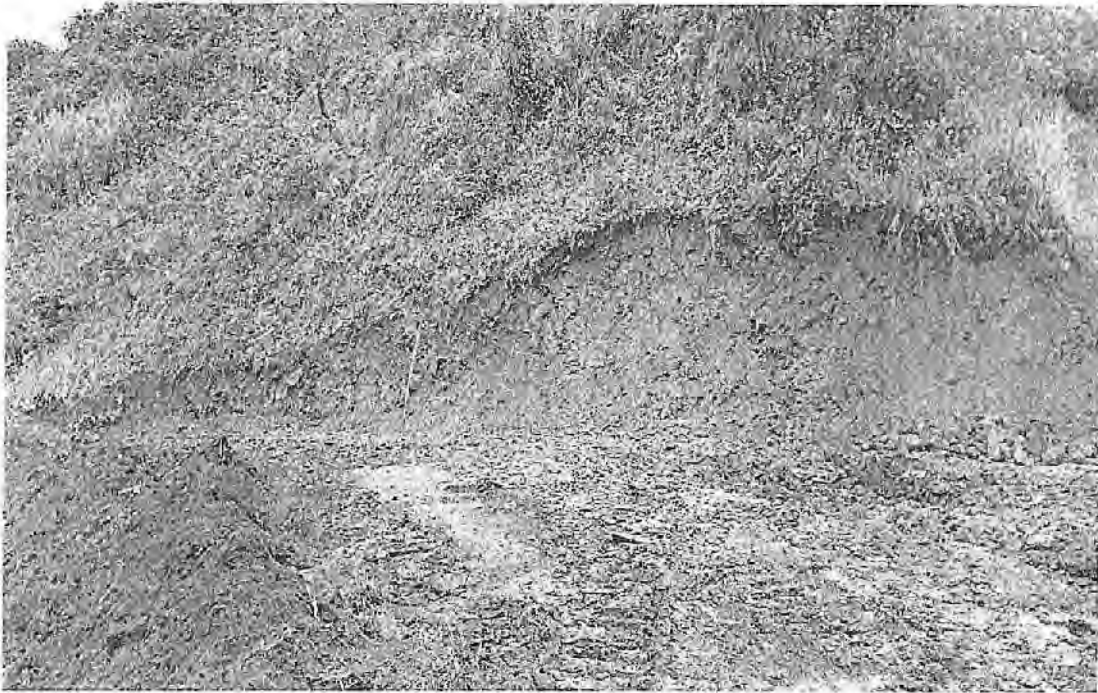
Se aprecia la plataforma para el pre filtro y reservorio después de la ejecución de la partida movimiento de tierras para el terraplén.
