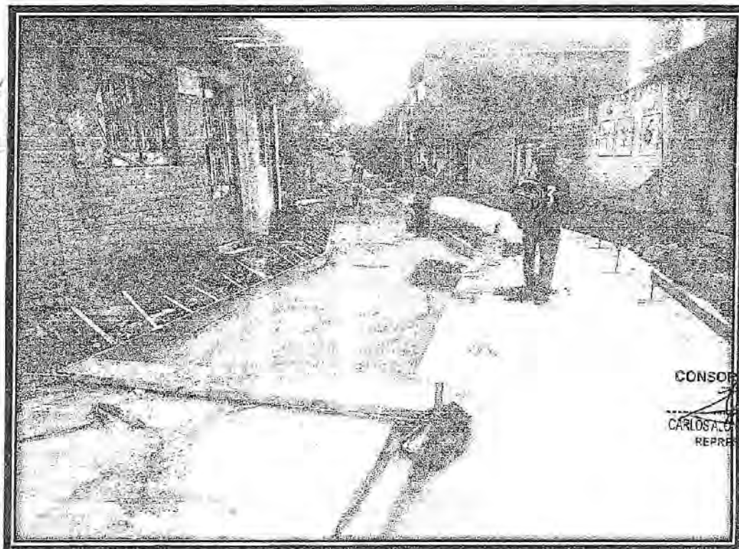
Fotografía 104: 06/11/19 habilitando zona de vaciado para pavimento de concreto f'c=210 en el Psj. Linares Cdra 02.
