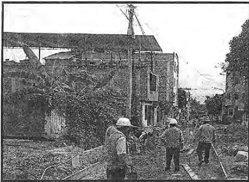
FOTO N°04: ENCOFRADO DE LOSAS MACIZAS CALLE IQUITOS PROG.0+200.
