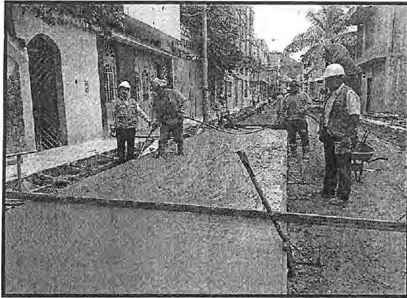
FOTO N°07: VIBRADO DE CONCRETO EN LOSAS MACIZAS CALLE LAS VIOLETAS PROG: 00+060
