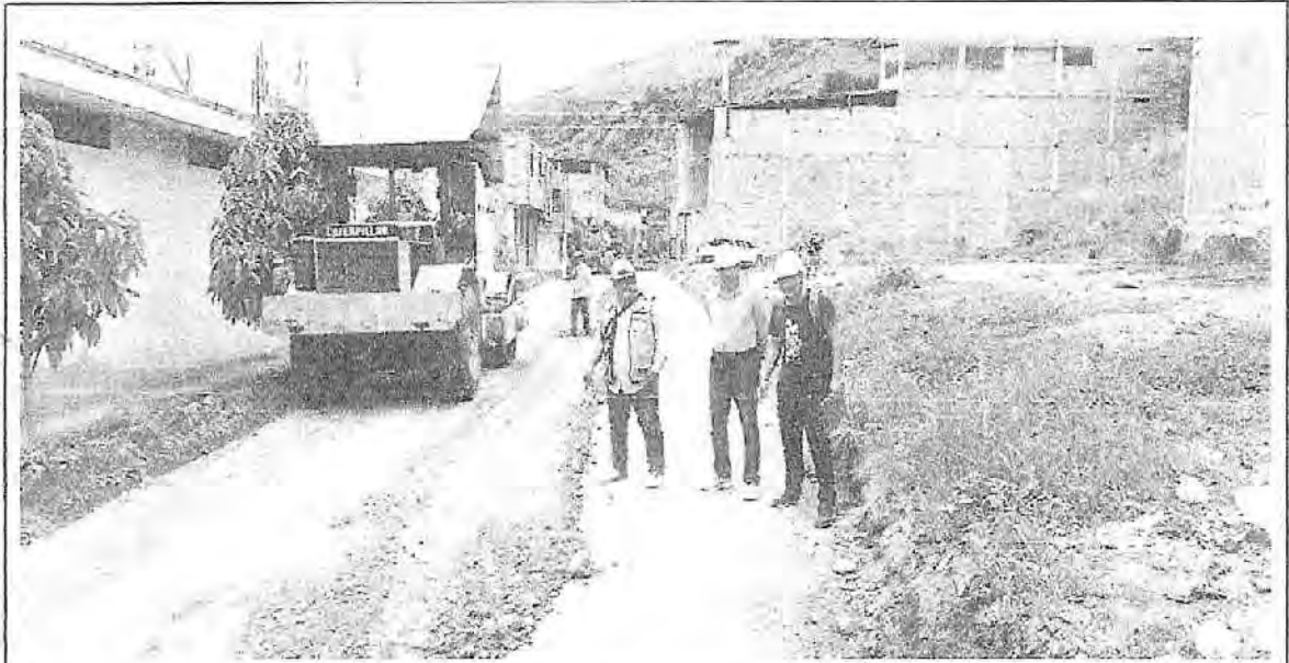
FOTOGRAFÍA 43 : Verificando trabajos de compactacion en calle Abancay cdr. 03.
