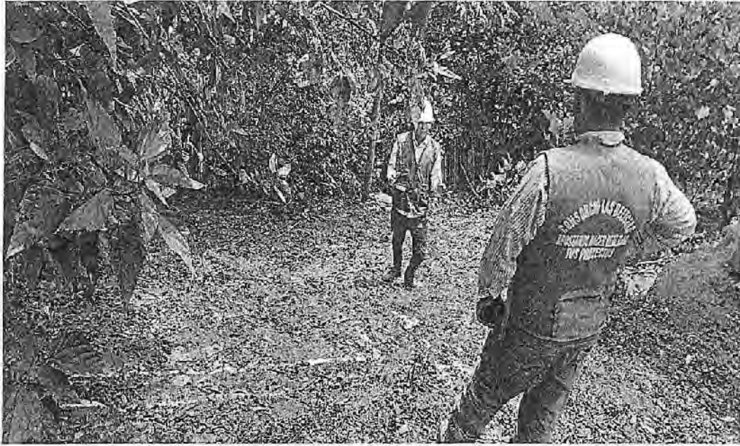
Otra vista donde se aprecia el Supervisor verificando el lugar. Donde irán los módulos UBS.
