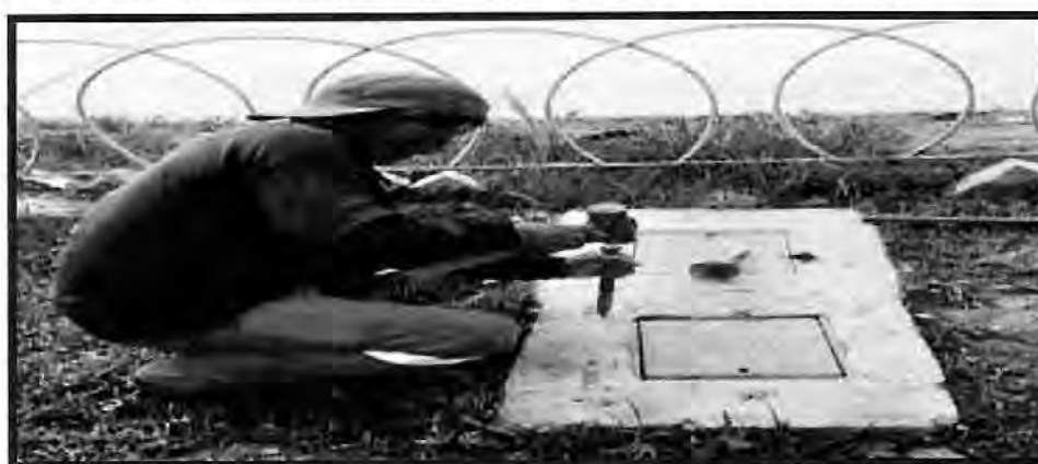
FOTO 38 .- Mantenimiento de sistema de riego en jardines y areas verde
