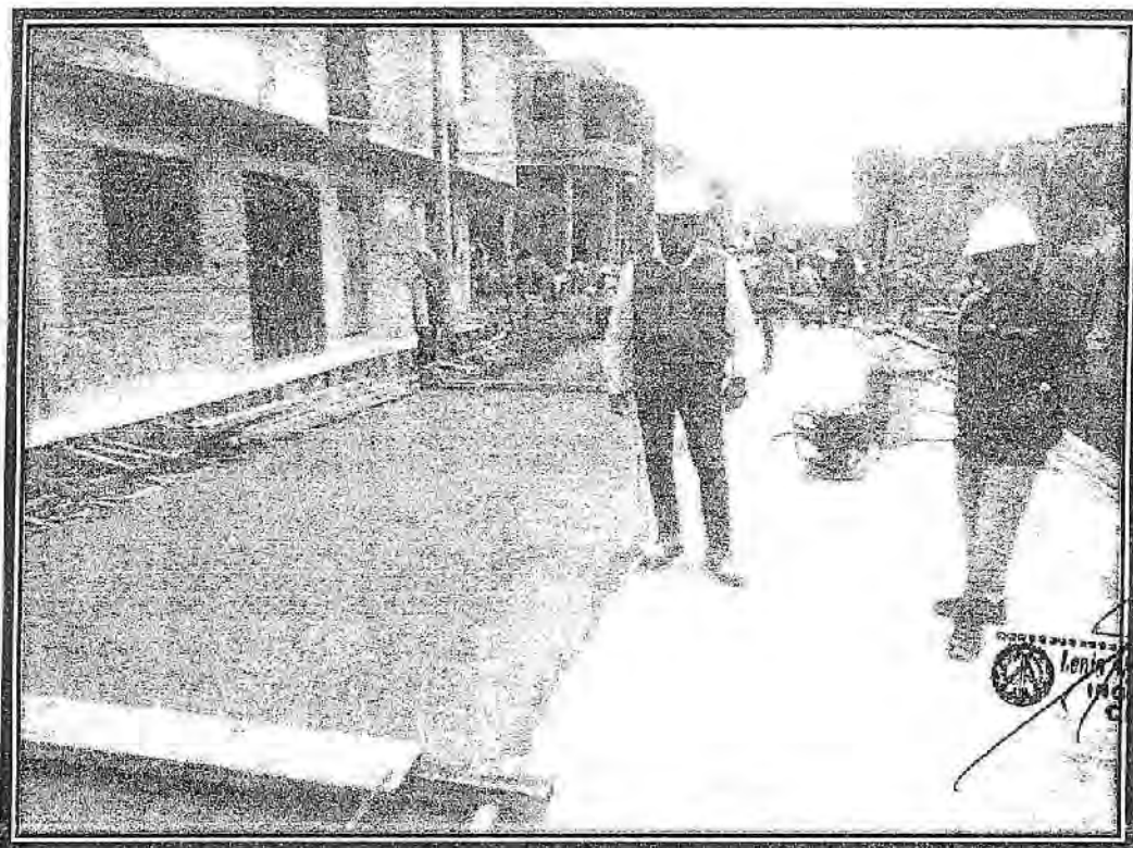
Fotografía 102: 05/11/19 Conformidad del supervisor en concreto f'c=210 de pavimento en la Calle Sucre Cdra. 26.
