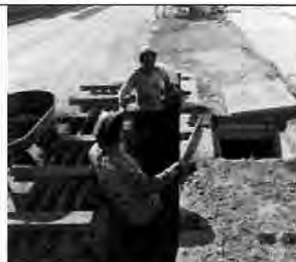
Foto N° 02. - Mantenimiento de drenajes pluviales con personal obrero
