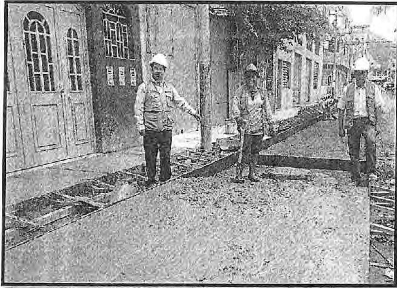
FOTO N°05: CONCRETO DE LOSAS MACISAS E=20CM, F'c=210 KG/CM 2 CALLE LAS VIOLETAS PROG: 00+060
