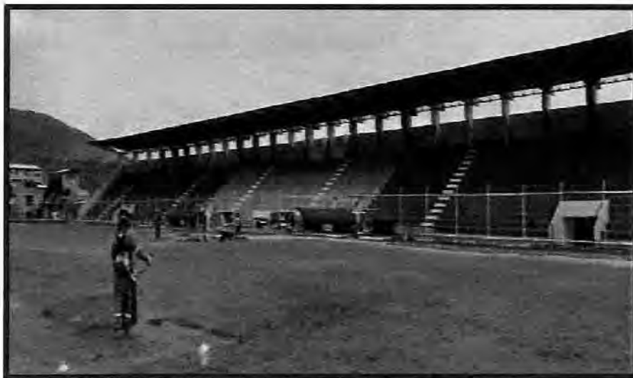
FOTO N° 12.- Estadio Municipal "Víctor Montoya Segura"
