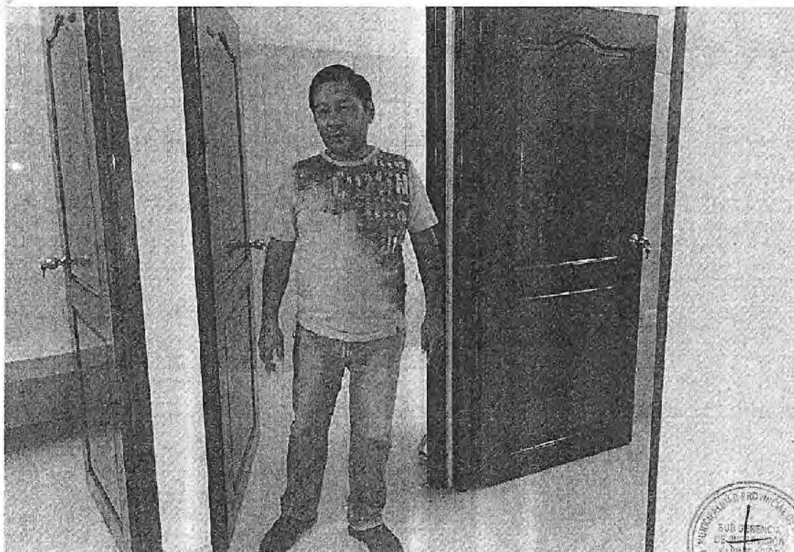
FOTO 04.- Se visualiza la culminación de la instalación de puertas de madera tipo apanelada para las áreas de los baños y vestidores de la obra.
