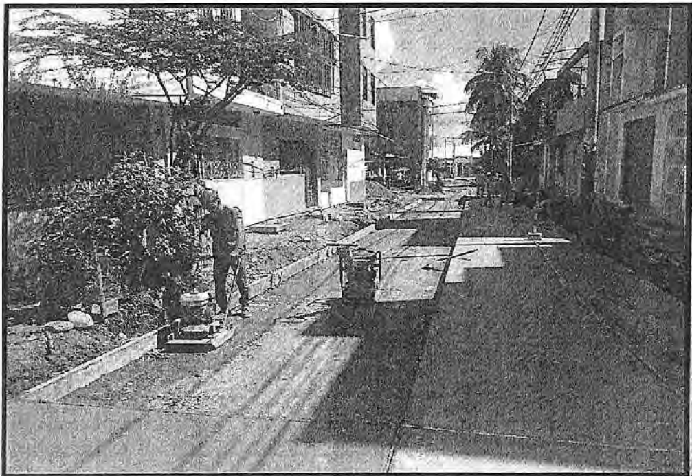
FOTO N° 02: ENCOFRADO Y DEENCOFRADO EN LOSA DE CONCRETO.
