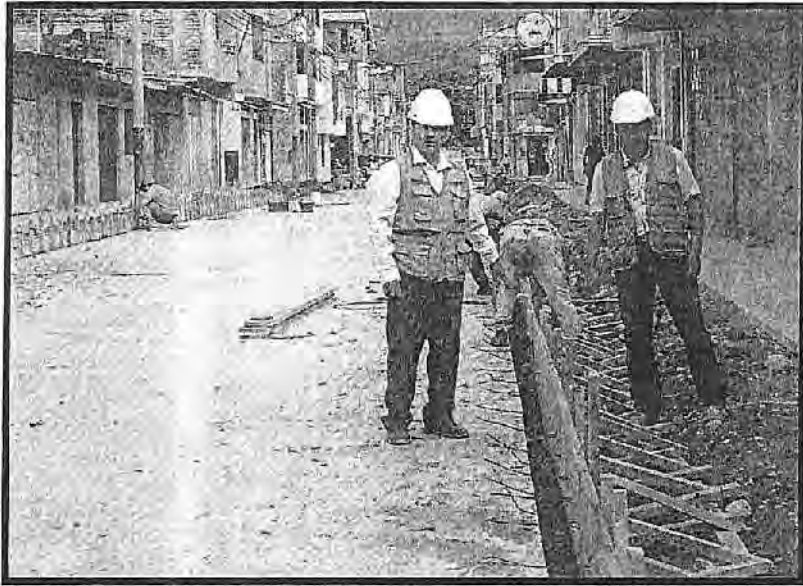
FOTO N°03: ENCOFRADO DE SARDINELES CALLE LOS LIRIOS PROG.0+010 MARGEN DERECHO
