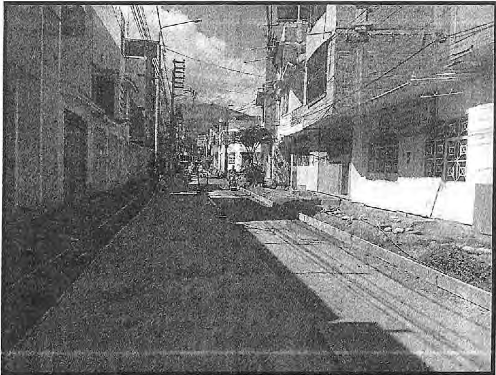
FOTO N° 01: ENCOFRADO Y DEENCOFRADO EN LOSA DE CONCRETO.
