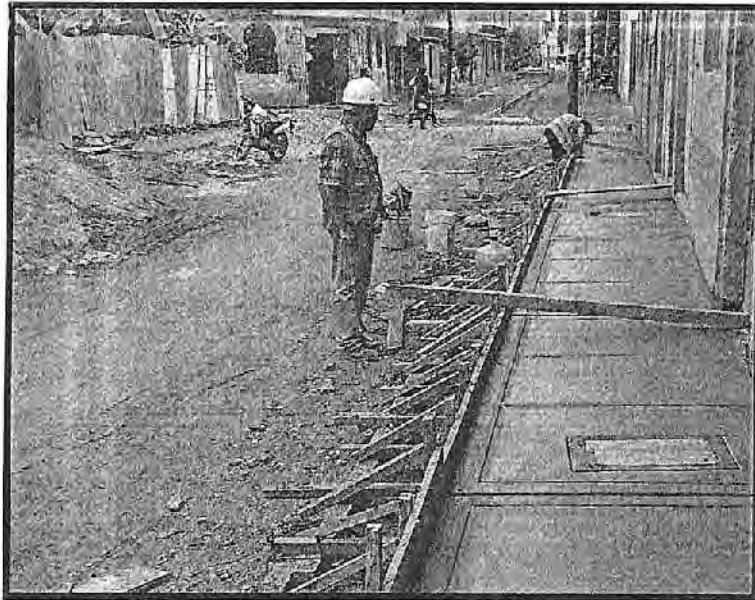
FOTO N°06: CONCRETO EN VEREDAS E=10CM, F'c=175 KG/CM 2 CALLE LAS VIOLETAS PROG: 00+090
