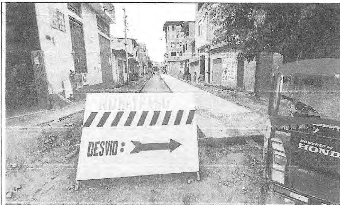
FOTOGRAFÍA 38 : Señalización de desvío de tránsito en obra.
