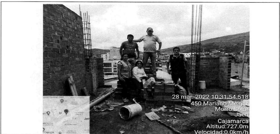
Supervisora de Obra haciendo seguimiento a las construcciones
