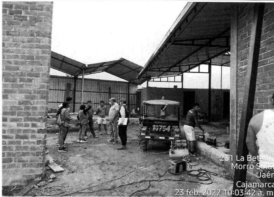
Supervisión de obra
